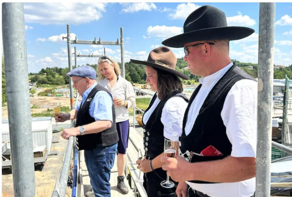
Konrad Moser (l.) von der gleichnamigen Holzbau-Firma hielt auf einem Gerüst in luftiger Höhe den Richtspruch. Er übermittelte sein Kompliment an alle am Bau Beteiligten.
